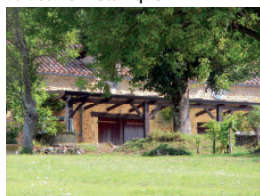
structure en bois
