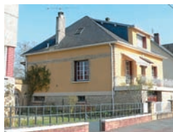
maison des années 50 : forme compacte, étage habitable sur rez-de-chaussée, escalier extérieur et soubassement en pierres
