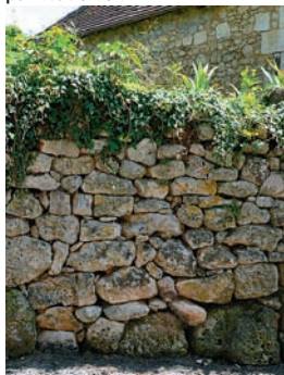
muret en pierre
