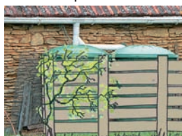
bacs à récupération d'eau
