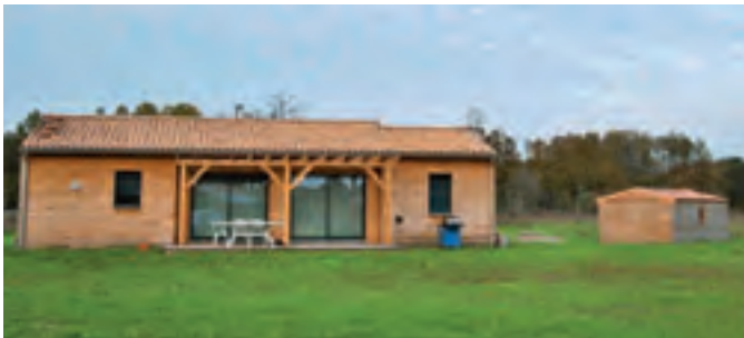
Pavillon bois avec annexe séparée
