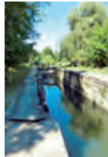
Ecluse et canal
